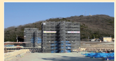
美囊川周辺の工事の状況
